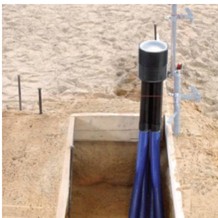
Bodeneinführung runde Ausführung
